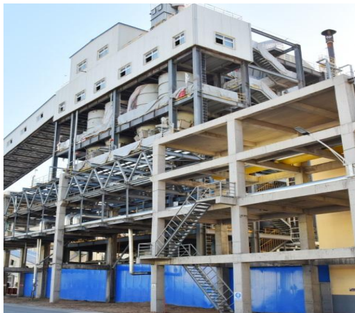
图 3 动力车间煤制气工段
